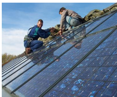
INSTALLATION DE PANNEAUX SOLAIRES
